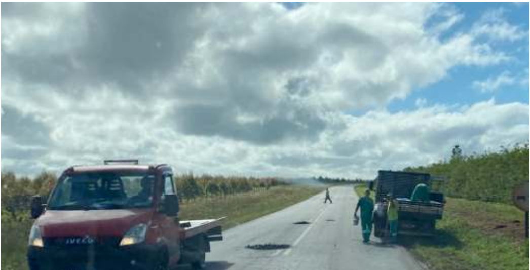
Prefeitura de Buri decidiu iniciar serviços de reparo em trechos considerados críticos, incluindo alguns de responsabilidade de Capão Bonito
