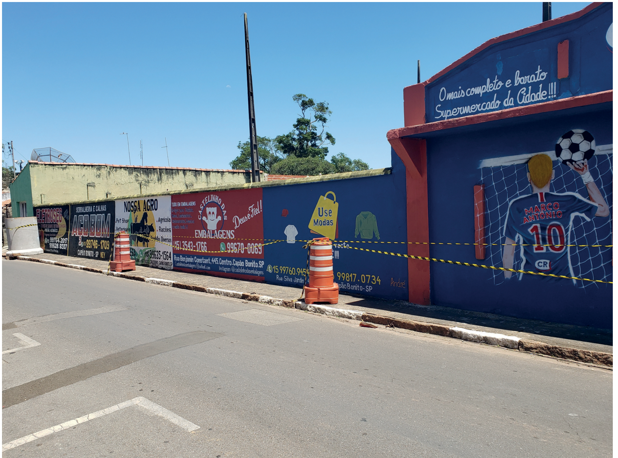
Estádio do Esporte foi interditado pela Defesa Civil de Capão Bonito
