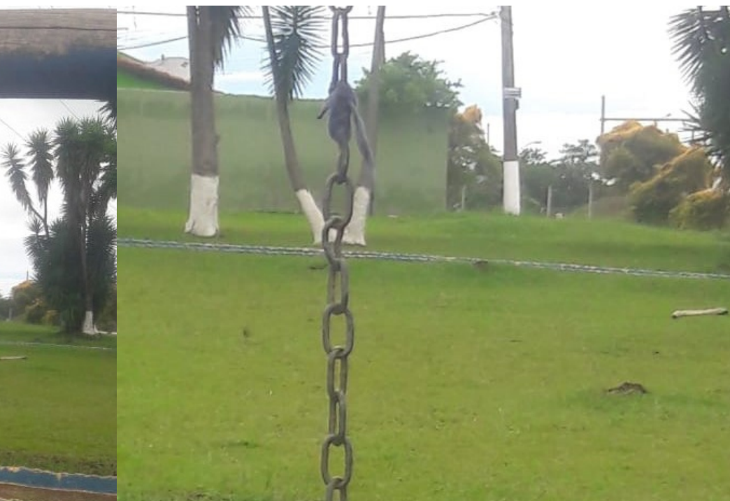
Corrente de balanço presa com pano
