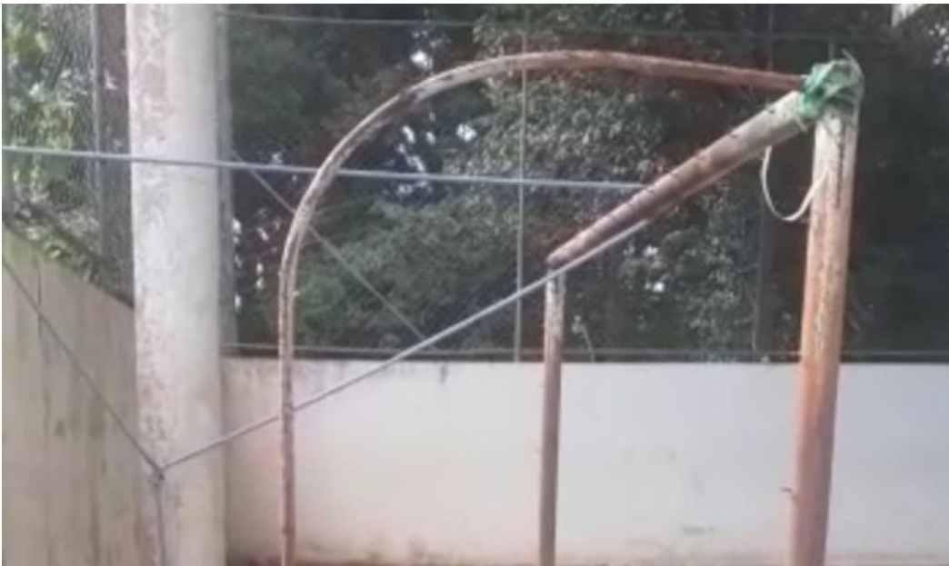
Trave está sendo segura por uma mangueira
